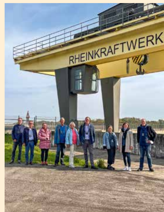
Zu Besuch im Rheinkraftwerk Iffezheim Foto: EUD Mainz
